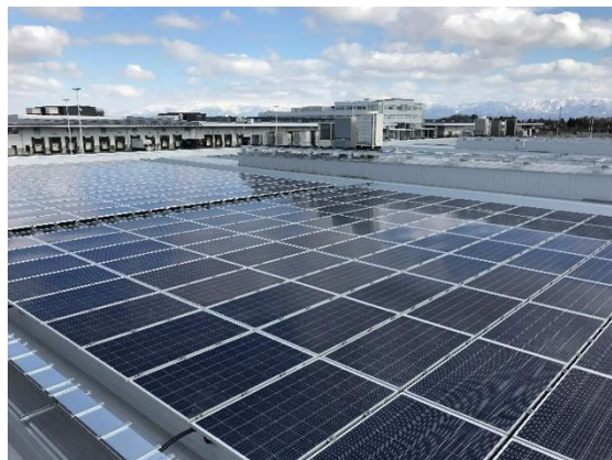
新潟市中央卸売市場 総合食品センター棟
